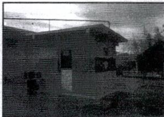
Foto 2: Casa de Proteção
